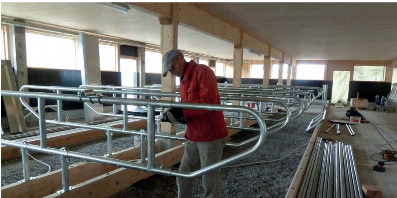
Rot. Fred Ort bei Montagearbeiten
